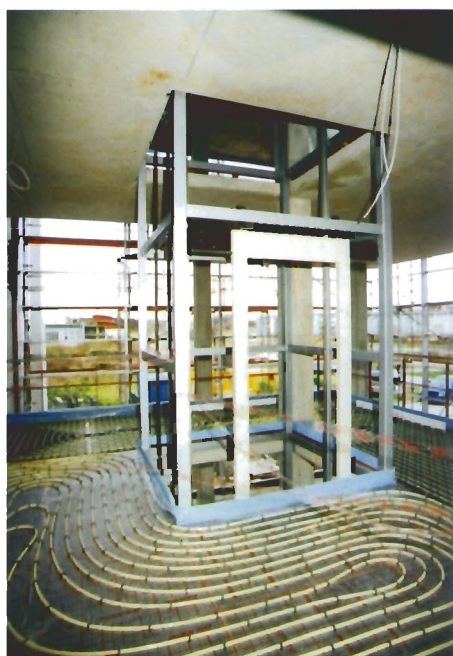
Verlegesituation proKLIMA mit Heiz-/Kühlrohr
