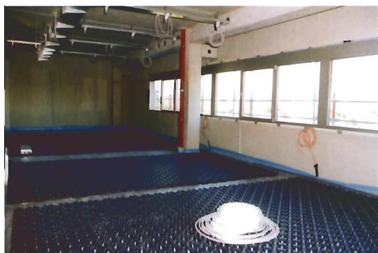
verlegter proKLIMA Systemboden
