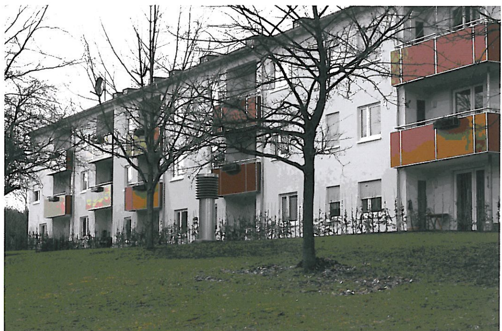
1 Denkmalgeschützt und energetisch neu: erster sanierter Block im Siegener „Vorderen Wensch“
