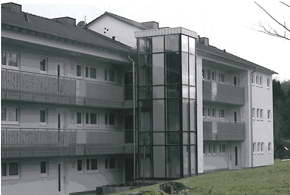
2 Auch von hinten ansehnlich und modern: zukunftsfähige Immobilie mit Laubengang und Glasfahrstuhl
